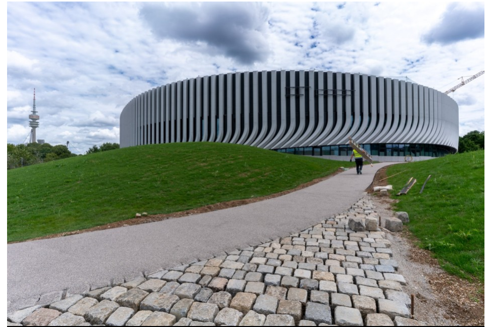
Baustellenaufnahme - Außenansicht West Josef Goldschmidt, München
